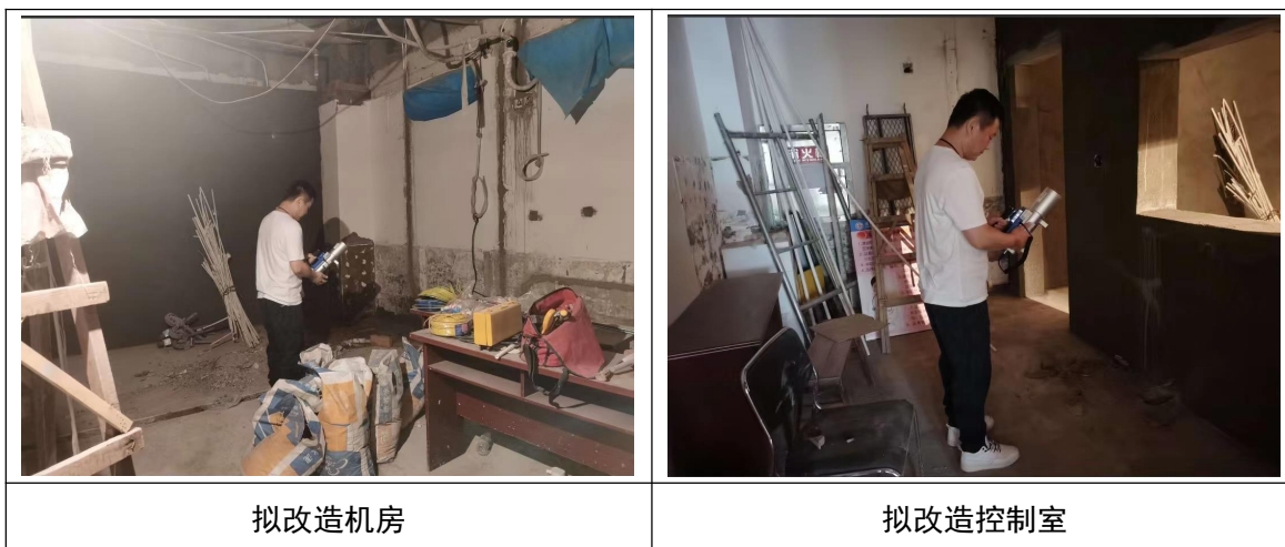
图 8-1 本项目机房改造前现场照片
